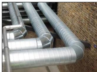
Крепление инженерных сетей и оборудования (водопроводов, воздухопроводов, фанкойлов, электрики и т.д.).
