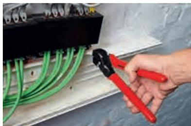
Клещи высечные Кнiрех для пластмассовых коробов вырезают самые распространенные профили в пластмассовых коробах и кабельных каналах просто, быстро и чисто. Никакого трудоемкого выпиливания или выкусывания и затрат на дополнительную обработку не требуется.
